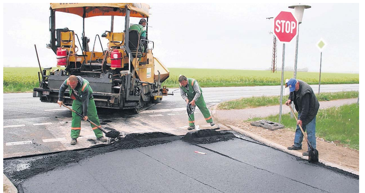
Im Frühjahr wurde die Hauptzufahrtstraße von der L 35 in den Daberkower Ortsteil Hedwigshof asphaltiert. Jetzt fand diese Baumaßnahme auch Einzug in den Haushalt der Gemeinde – per Nachtrag.
